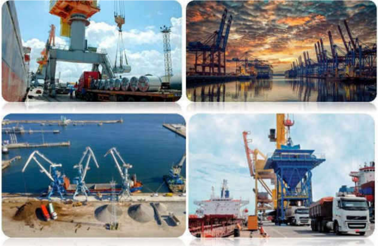
Hình 4.12. Minh họa thiết bị bốc xếp trên bến cảng
