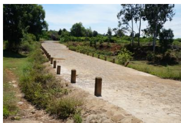
Đập tràn hồ Vân Hòa
