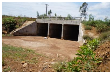
Cống qua đường
