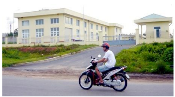
Trạm tăng áp Nhơn Trạch Công suất 70.000\text{m}^3/\text{ngđ}
