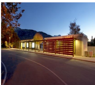
Nhà vệ sinh công cộng được kết hợp với bến xe trên đường phố
