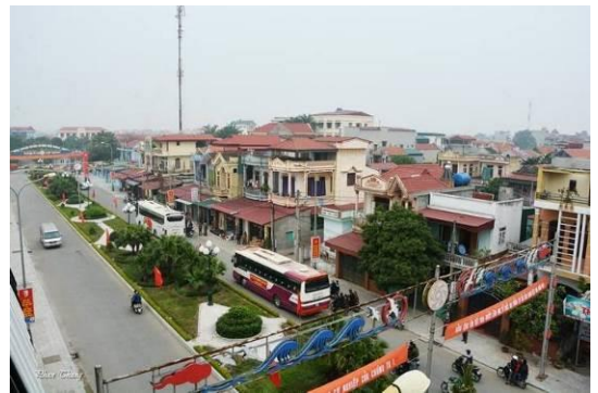
Nhà mái bằng BTCT
