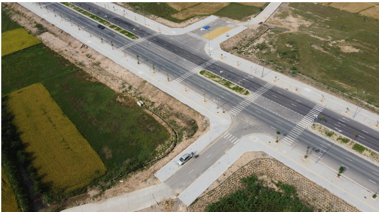
Hình 9: Hiện trạng hạ tầng kỹ thuật đường ĐT.638 (đường Long Vân – Long Mỹ)
