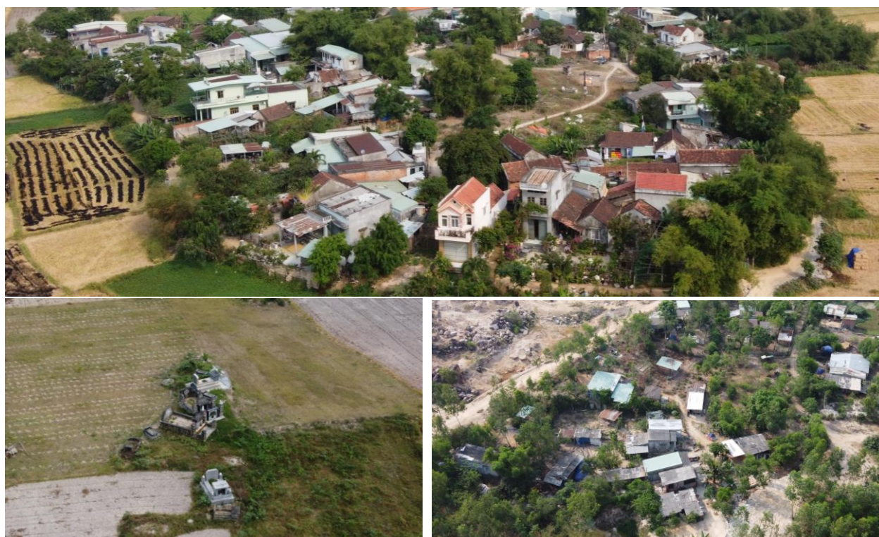
Hình 7: Hiện trạng vật, kiến trúc
