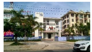
(A10) Cty. xây dựng 8
