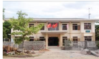
(A33)Trụ sở UBND phường Võ Dạ
