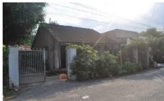
Nhà ở thấp tầng cũ (phía Bắc trục đường CMT8)
