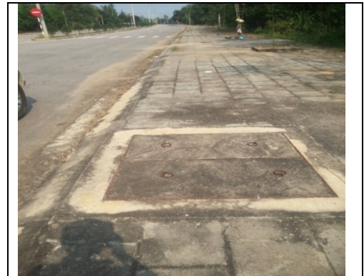
Cống thoát nước
