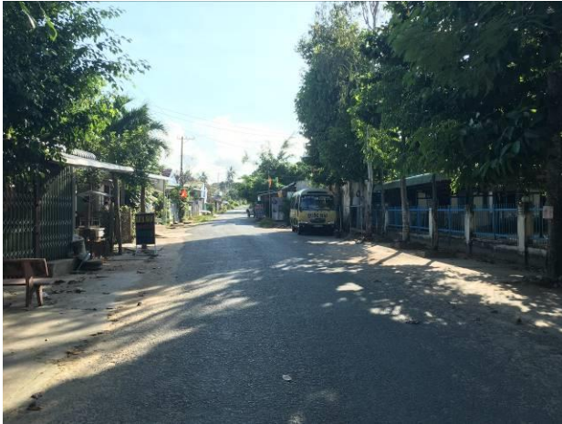
Hình ảnh đường Vành Đai không có hệ thống thoát nước đường
