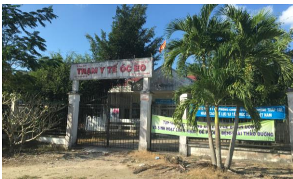
Trạm y tế Óc Eo
