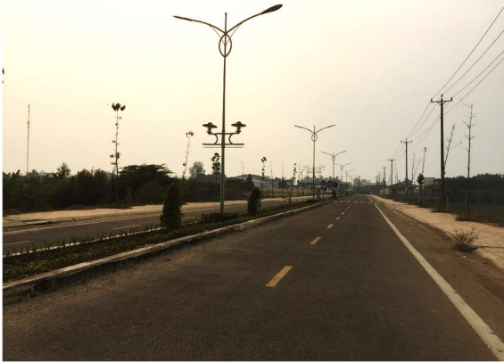
Hình ảnh hiện trạng đường tránh
