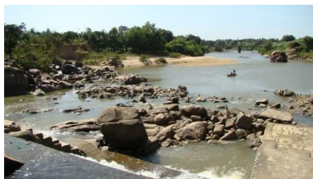
Đập Đá Dựng
