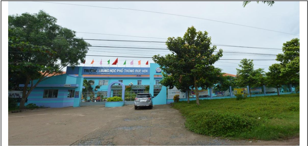
Hình 12: Công trình giáo dục tại TT. Đức Hòa
