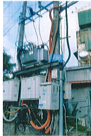
TBA TT SƠN TỊNH 8. (22/0.4KV-400KVA)
