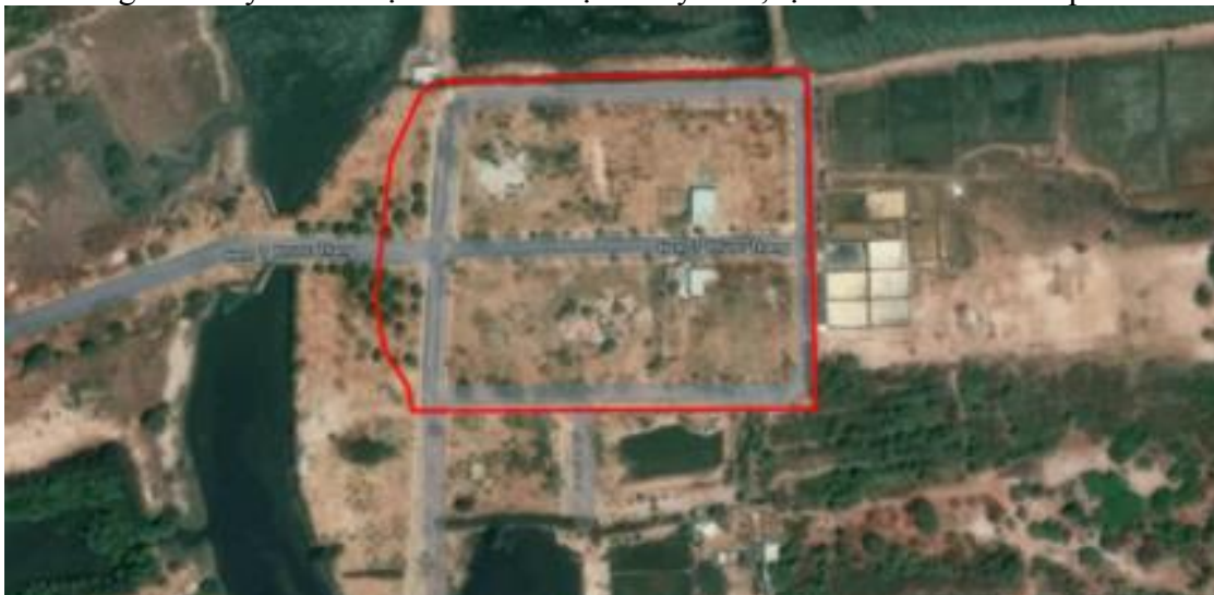
Hình 26 – Hiện trạng dự án nhà ở thấp tầng tại phường 12, tp. Vũng Tàu.
