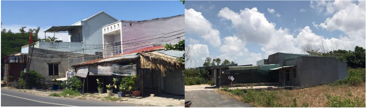
Hình 13 – Nhà ở hiện hữu trong khu vực quy hoạch
