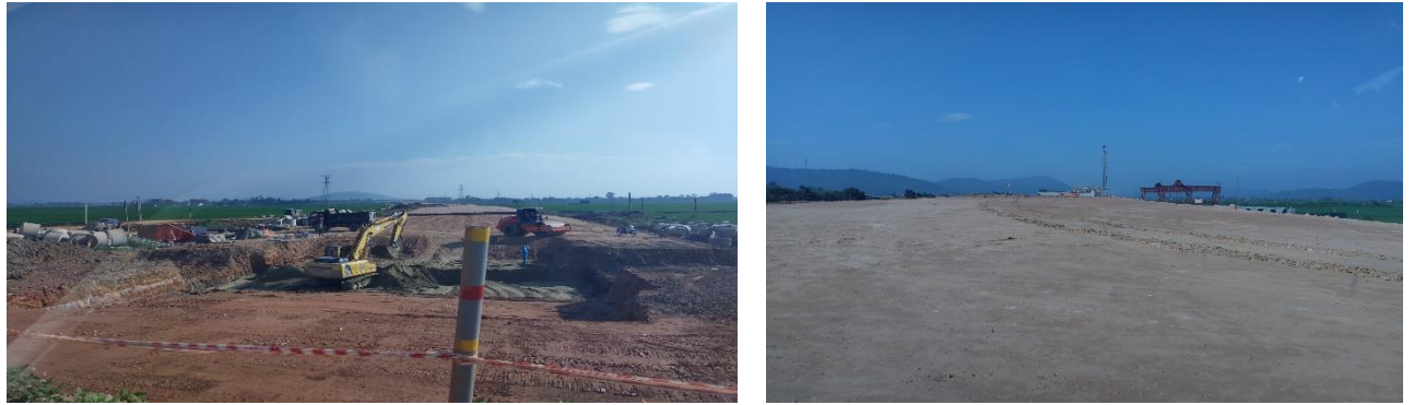
Hình 2.5. Hiện trạng triển khai tuyến cao tốc Bắc - Nam
