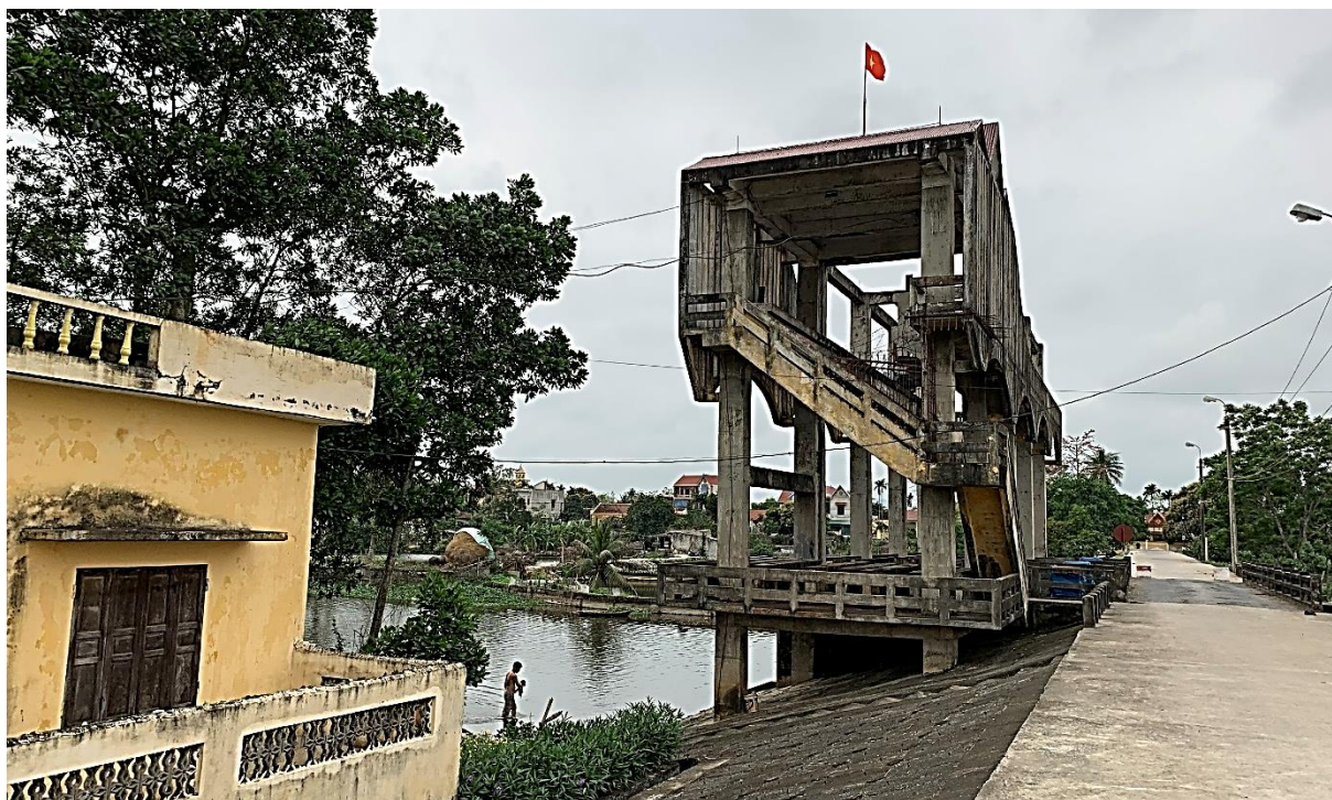
Hình 2-2: Ảnh khu vực cống Bộ Đầu
