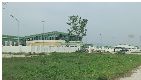
Nhà máy Viet Avis (đường tránh QL1)
