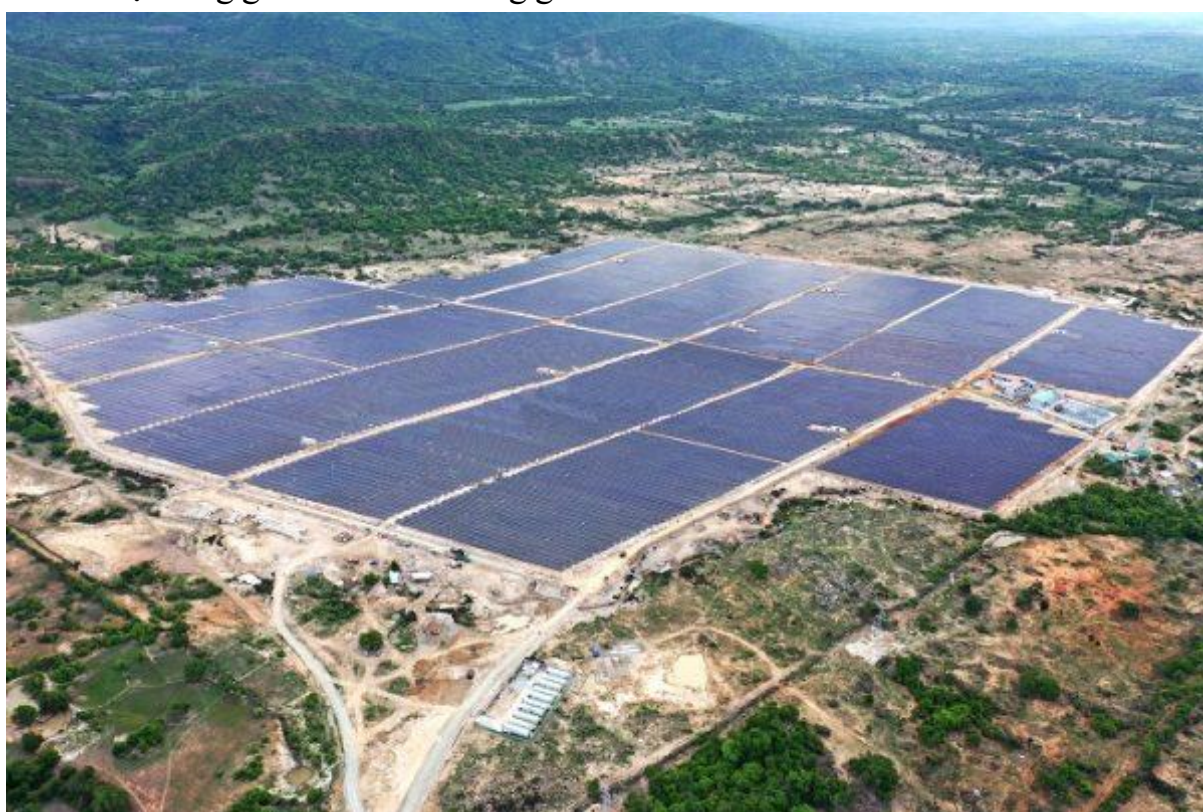
Nhà máy điện năng lượng mặt trời Phước Hữu với công suất 330Wp
