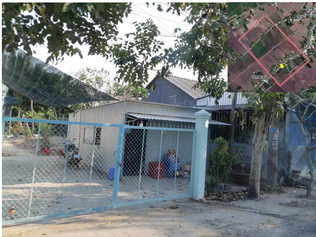
Hình 5: Hiện trạng kiến trúc
