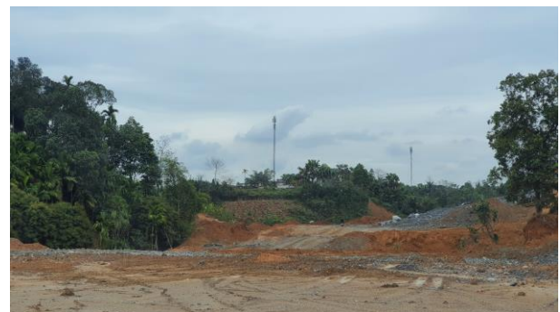
Đường Quốc lộ 32C đang thi công (vị trí đường lên cầu Tuần Quán)
