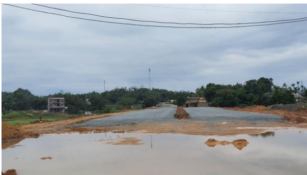
Đường Quốc lộ 32C đang thi công (vị trí đường lên cầu Giới Phiên)
