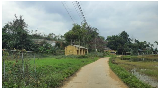
Đường bê tông hiện trạng (4,50-5,50m)
