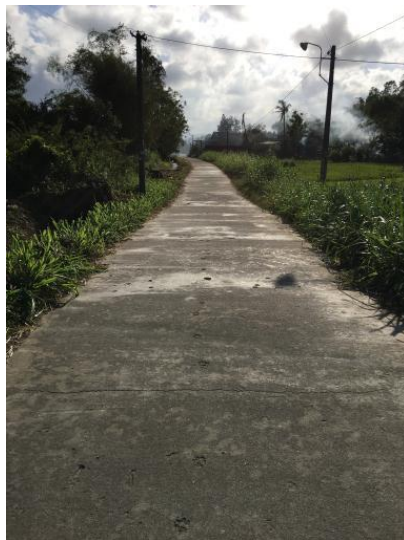
Đường bê tông nông thôn
