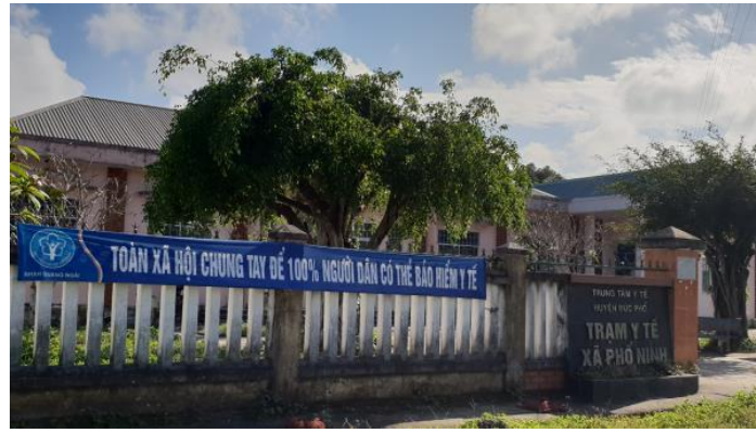
Trạm y tế phường Phở Ninh
