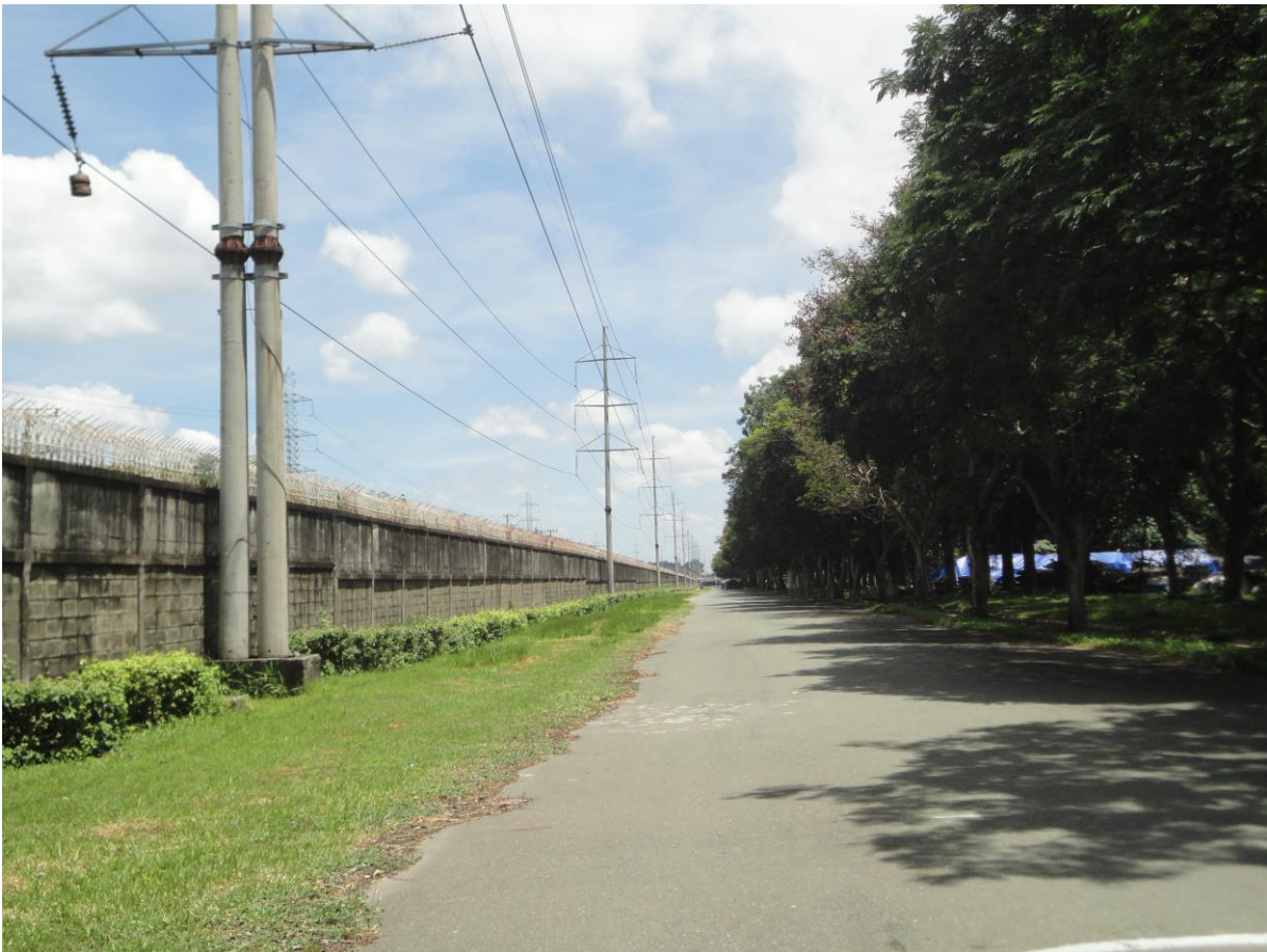
Hình 15: Tuyến điện 110KV chạy dọc đường Cảng Gò Dầu A.
