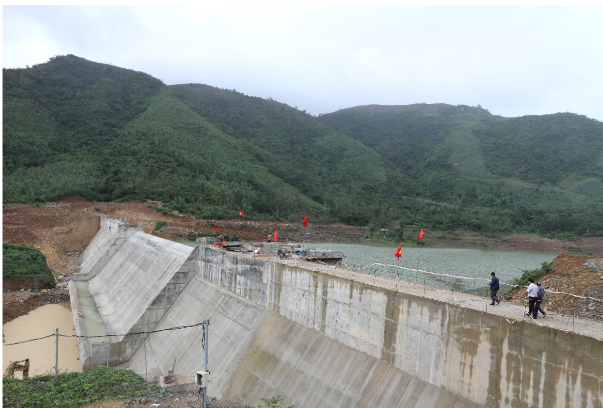
Hình 1. Thi công đập thủy lợi Hồ Lỗ Chài 1
