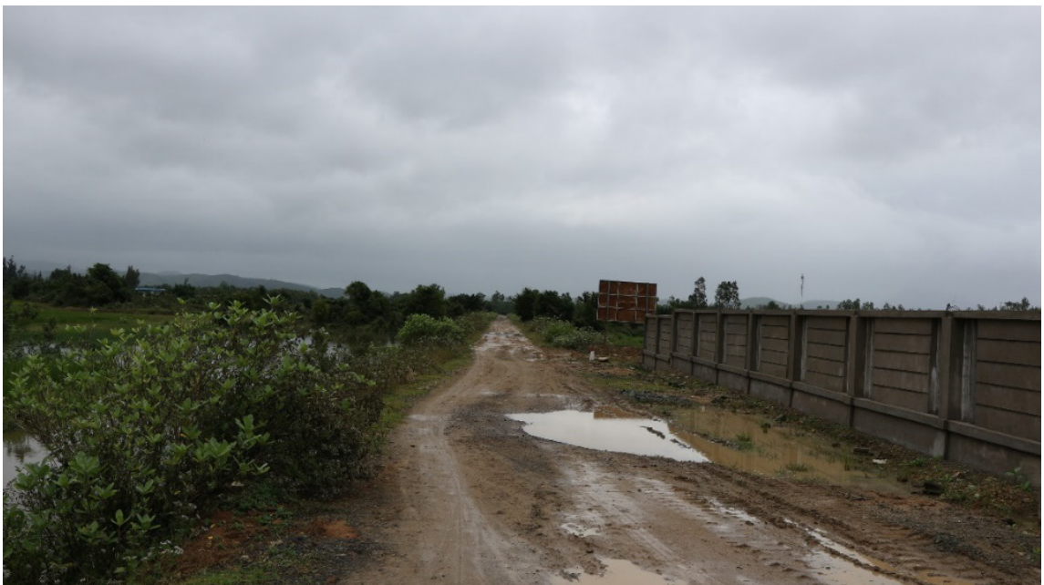
Hình 7. Hạ tầng đang thi công trước Trung tâm nghiên cứu và phát triển nông nghiệp CNC Phú Yên
