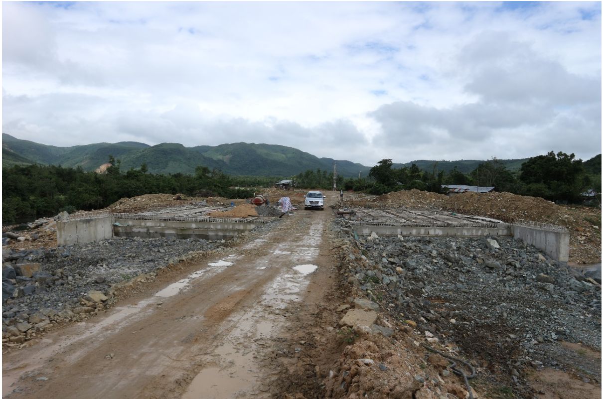
Hình 4. Cầu suối Mộc đang thi công xây dựng
