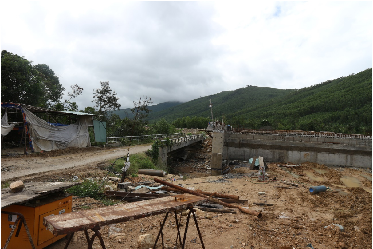
Hình 3. Cầu Lỗ Chài đang thi công xây dựng
