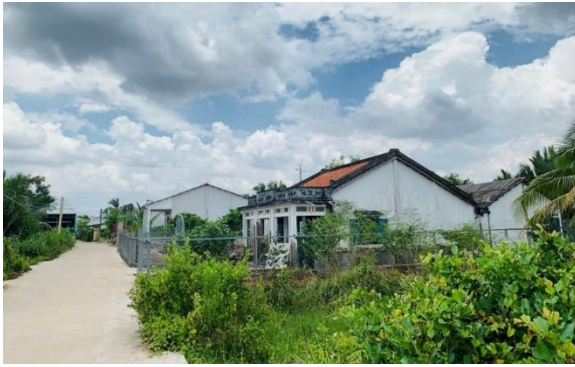
Kiến trúc nhà cấp 4
