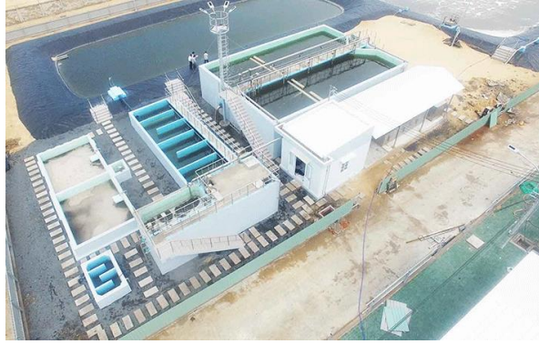
Hình 54- Trạm xử lý nước thải
