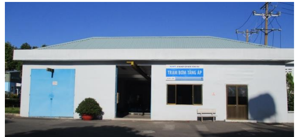
Hình 24- Trạm bơm tăng áp Nguyễn An Ninh Công suất 30.000m 3 /ngđ
