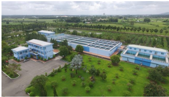
Hình 23- Nhà máy nước hồ Đá Đen Công suất 100.000m 3 /ngđ
