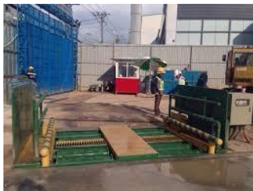
Hình 53- Rửa xe khi ra khỏi công trường
