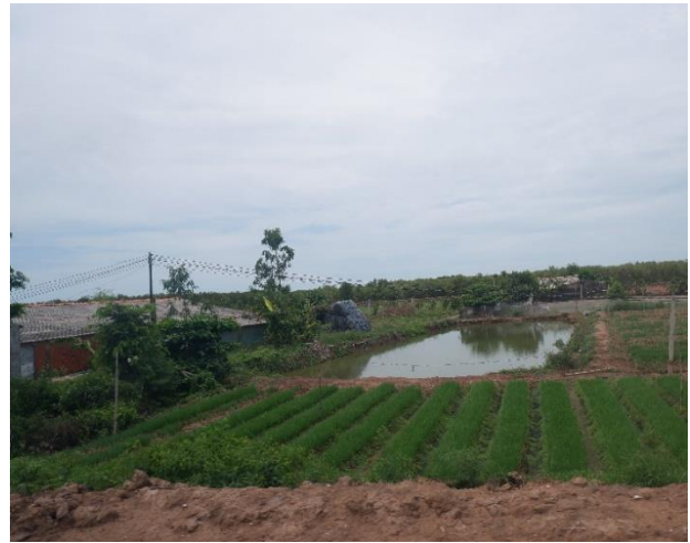
Nhà ở phân tán đường đê biển
