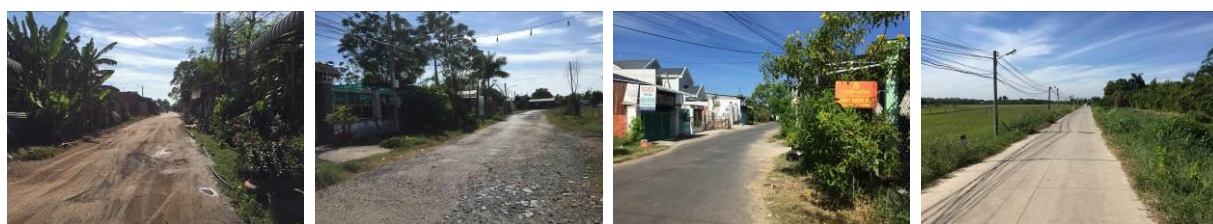
Hình 12: Hình hiện trạng giao thông nội bộ
