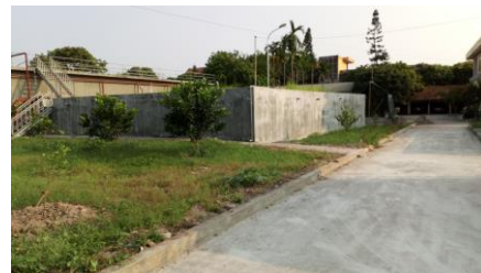
Bể chứa NMN Vĩnh Trụ
