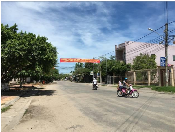
Đường Nguyễn Văn Trỗi có mương nắp đan thoát nước bên đường
