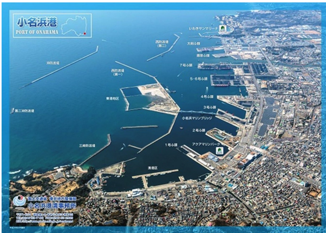
Hình 3.6: Toàn cảnh cảng Onahama do VP cảng Onahama, Nhật Bản cung cấp
