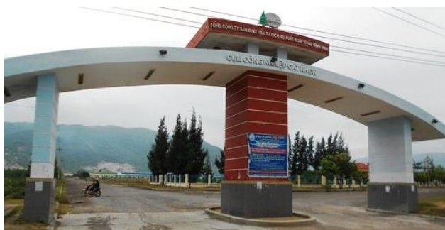
Hình 26- Cụm công nghiệp Cát Nhơn
