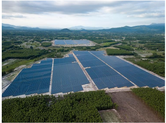
Hình 28- Nhà máy điện mặt trời Cát Hiệp
