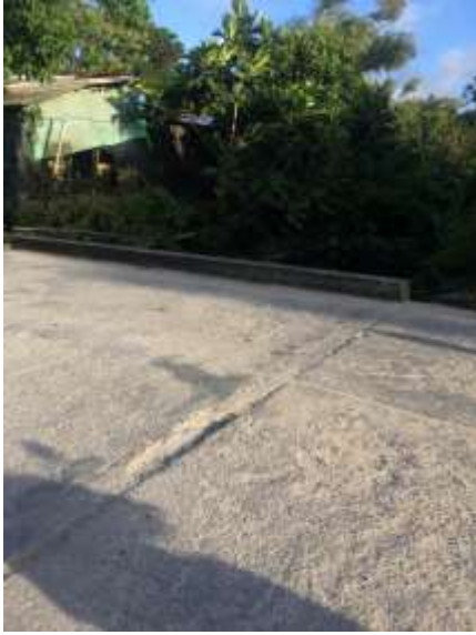
Mương thoát nước
