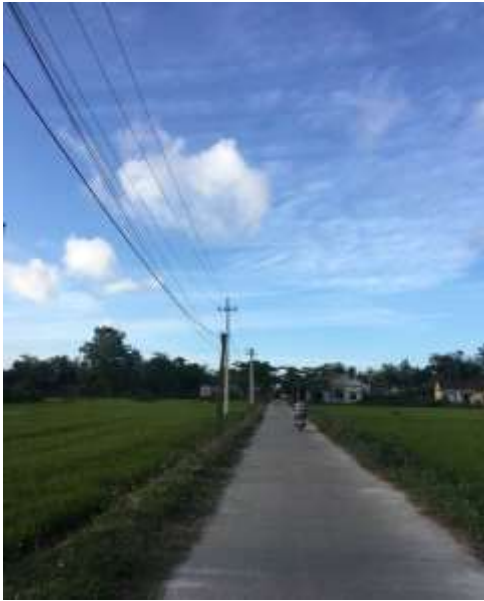
Đường bê tông nông thôn
