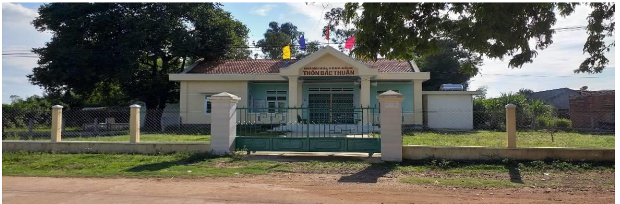
Nhà văn hóa thôn Bắc Thuận
