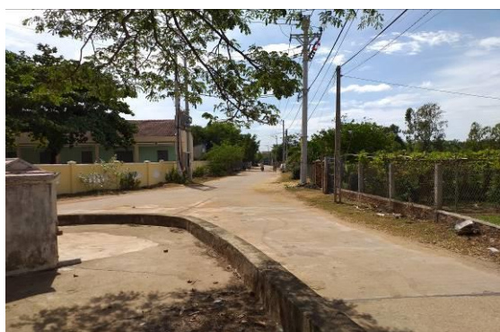
Đường điện tại đường Nguyễn Nhạc
