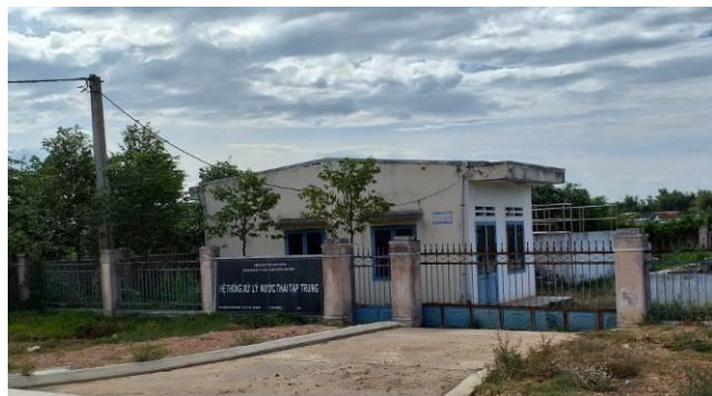
Trạm xử lý nước thải tại cụm công nghiệp Gò Đá Trắng bỏ hoang
