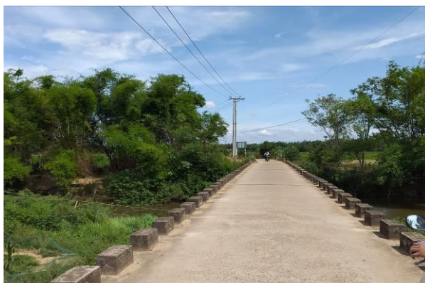
Cầu qua sông Quai Vạc
