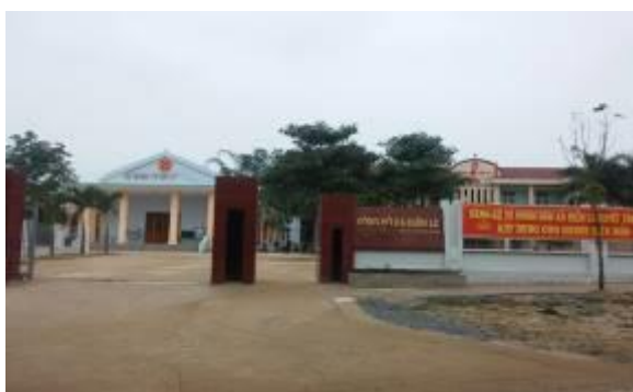
Công sở xã Điện Lư
