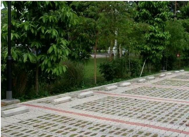
Hình 6. 5: Bãi đỗ xe sử dụng vật liệu lỗ rỗng, cho phép thấm nước (trái) và bãi đỗ xe chống ngập – WSUD (phải)
