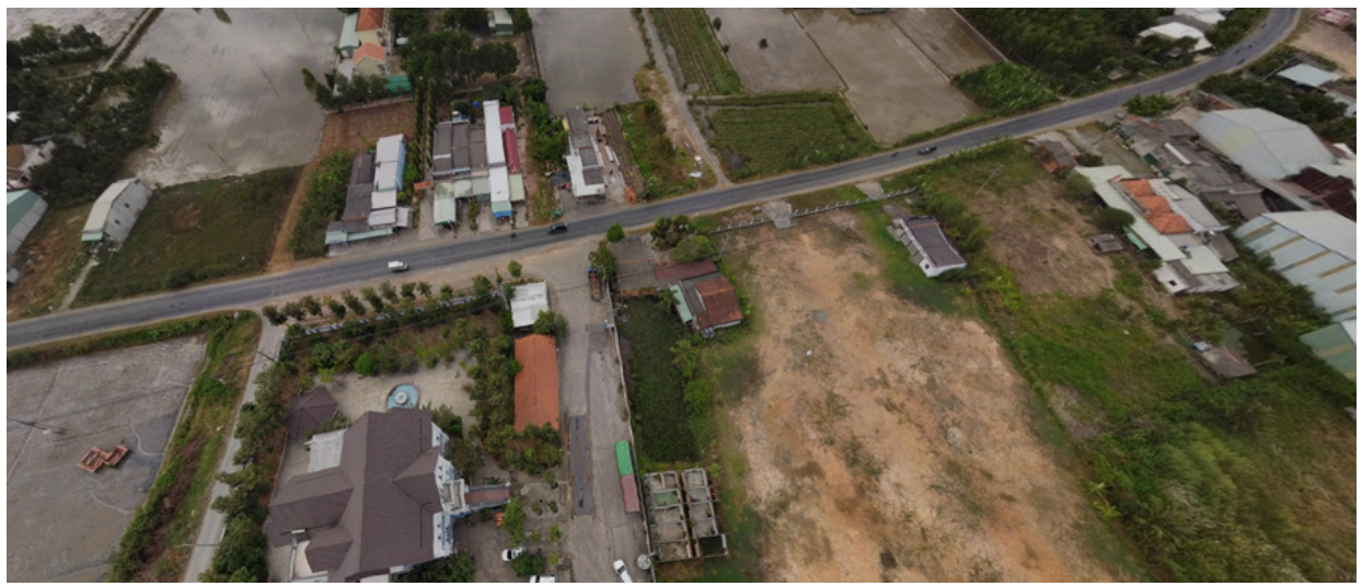
Hình 6. Ảnh chụp hiện trạng khu dân cư và trục Quốc lộ 62
