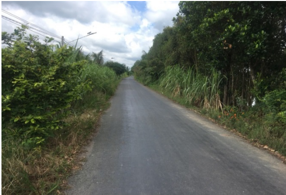
Tuyến đường cặp kênh T3
