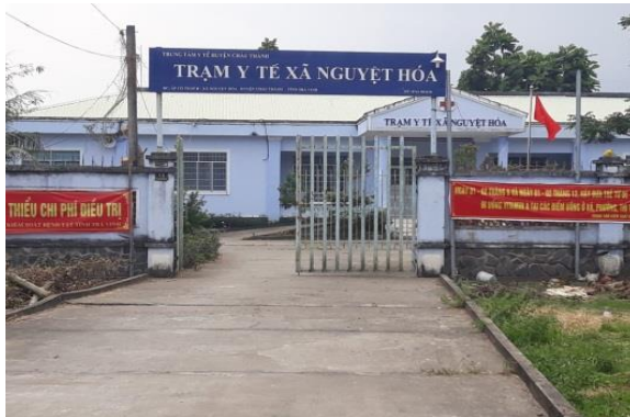
Trạm y tế xã Nguyệt Hóa
