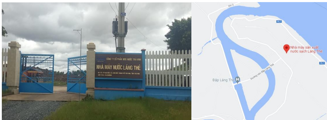
Nhà máy nước sạch Láng Thê
