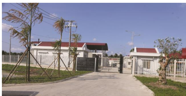
Nhà máy nước sạch Nguyệt Hóa
