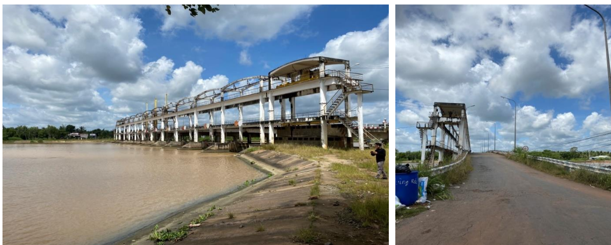
Công đập Láng Thè
