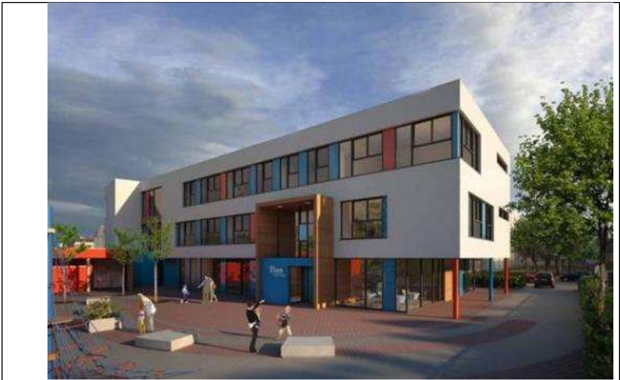
Công trình Giáo dục
