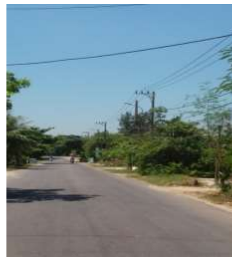
Lưới 22kV trên đường 607B
