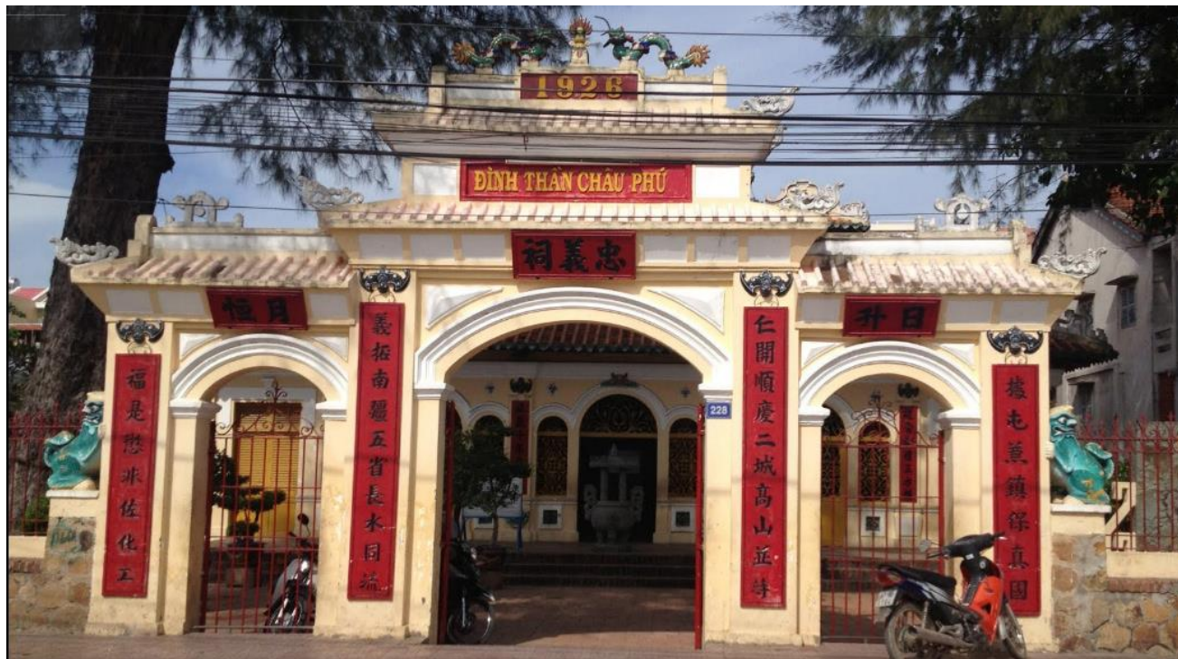
HÌNH 5: HÌNH ẢNH HIỆN TRẠNG MỘT SỐ CÔNG TRÌNH TÔN GIÁO TIÊU BIỂU
