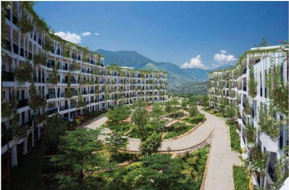
Minh họa khu nhà ở xã hội cho công nhân với chất lượng cao
