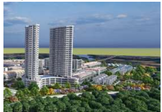
Công trình chung cư thương mại cao 30 tầng ở vị trí nằm trên trục đường nối Quốc lộ 19C
