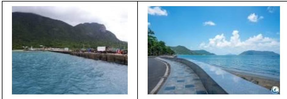
Kè khu vực cảng Bến Đầm
