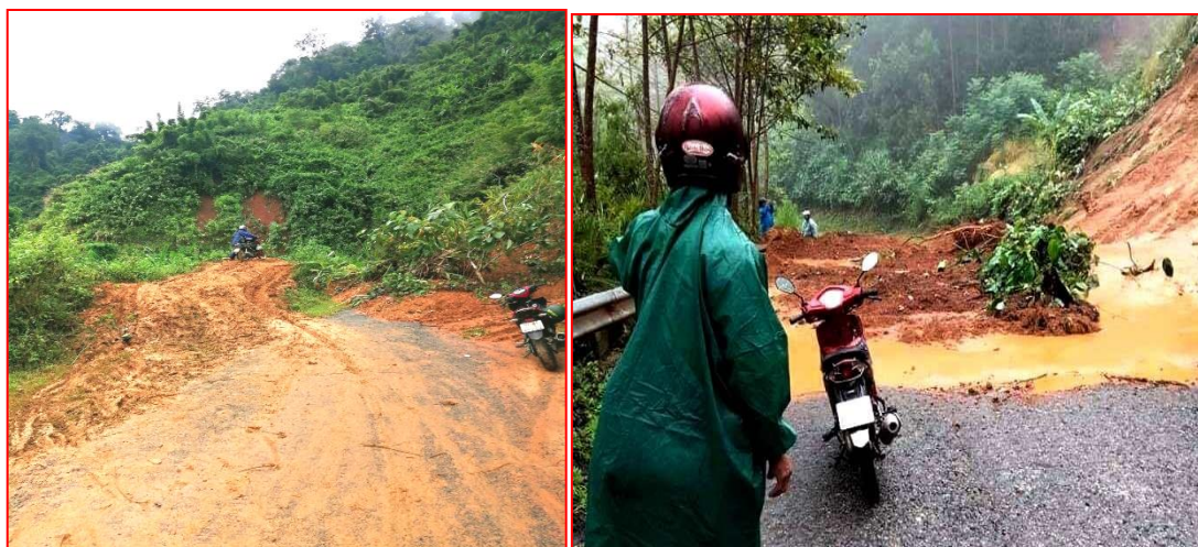
Sạt lở do mùa mưa lớn năm 2020 tại xã La Êê (nguồn thực tế)
