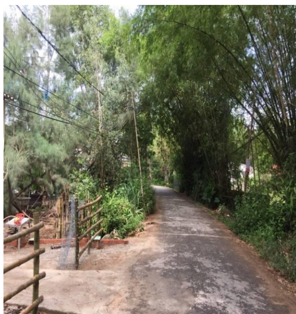
Lưới điện 0,4 kV hiện trạng trong các thôn xóm
