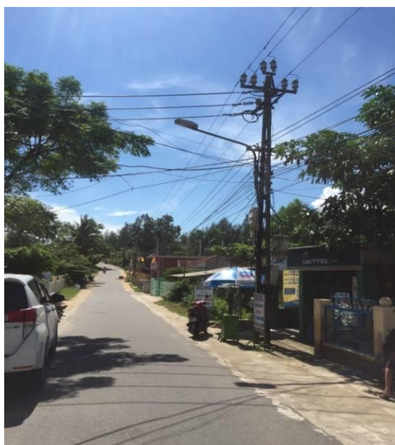
Hiện trạng cấp điện khu vực
