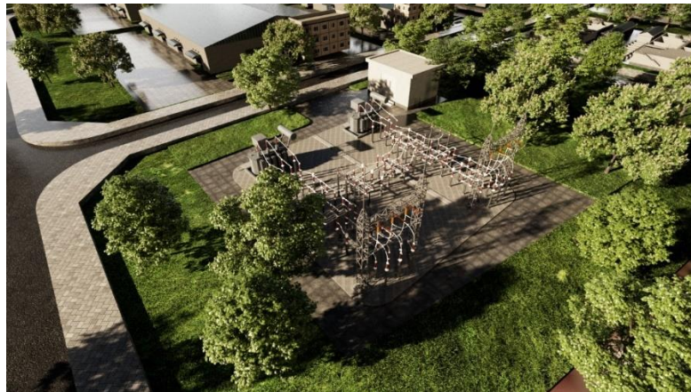
Hình ảnh minh họa Trạm Điện 110kv
