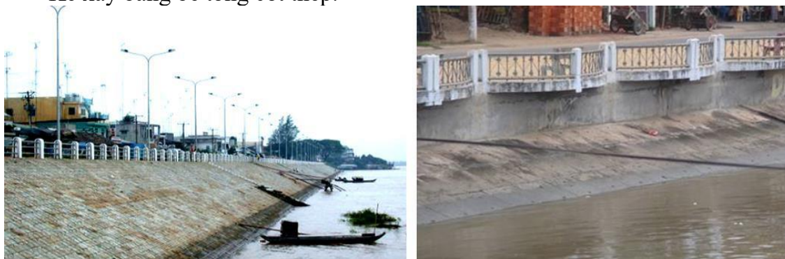
Hình 54: Giải pháp xây dựng công trình kiên cố phòng chống sạt lở đất
