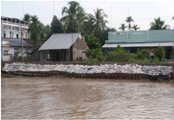
Hình 52: Một số giải pháp công trình thô sơ phòng chống sạt lở đất
