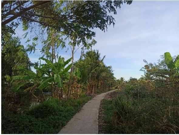
Đường bê tông cặp kênh thủy lợi
