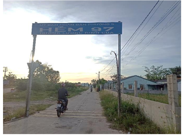
Đường bê tông hẻm 97
