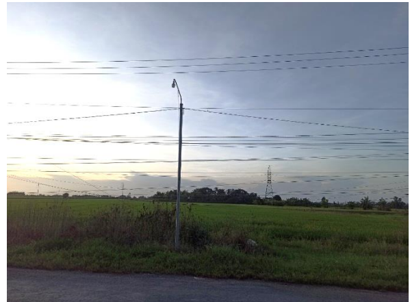
Đường điện cao thế ngang ruộng
