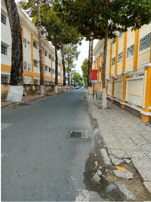
Hệ thống thoát nước Đ. Đinh Tiên Hoàng
