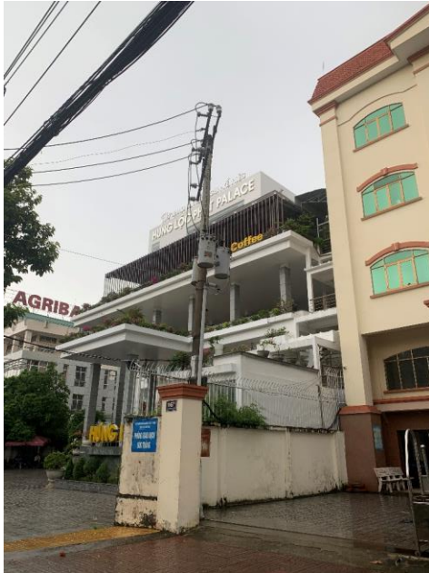
Tuyên điện Đ. Trần Hưng Đạo
