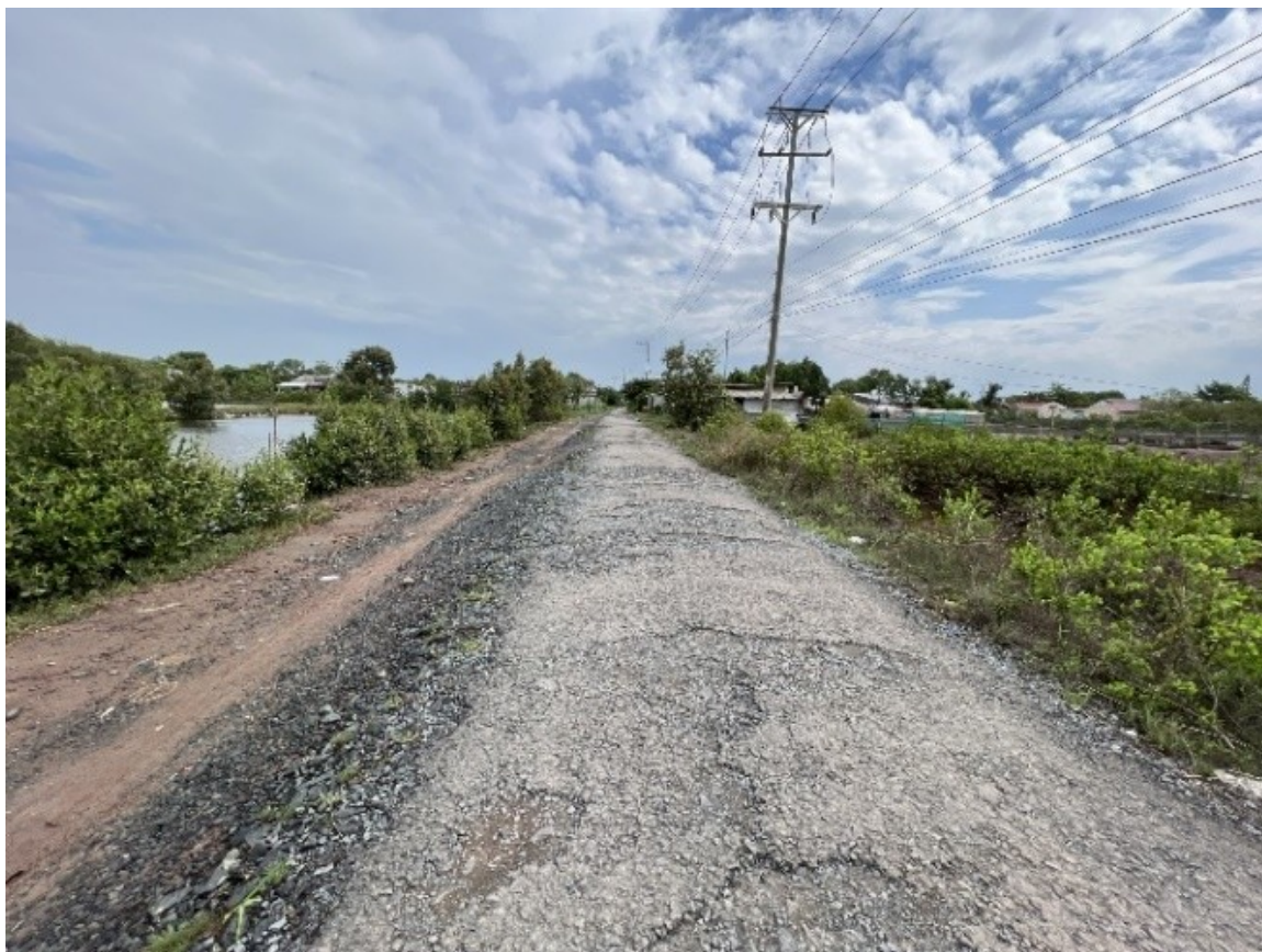
Hình 20. Đường điện trung thế
