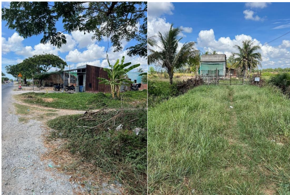
Tuyến kênh bị lấn chiếm trên đường tỉnh 935
